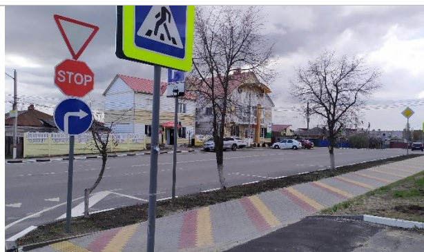
Фото 13. Окружающая застройка, подъездные пути
