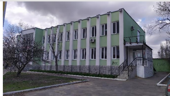
Фотография 3.1. Внешнее состояние нежилого помещения - основной части
